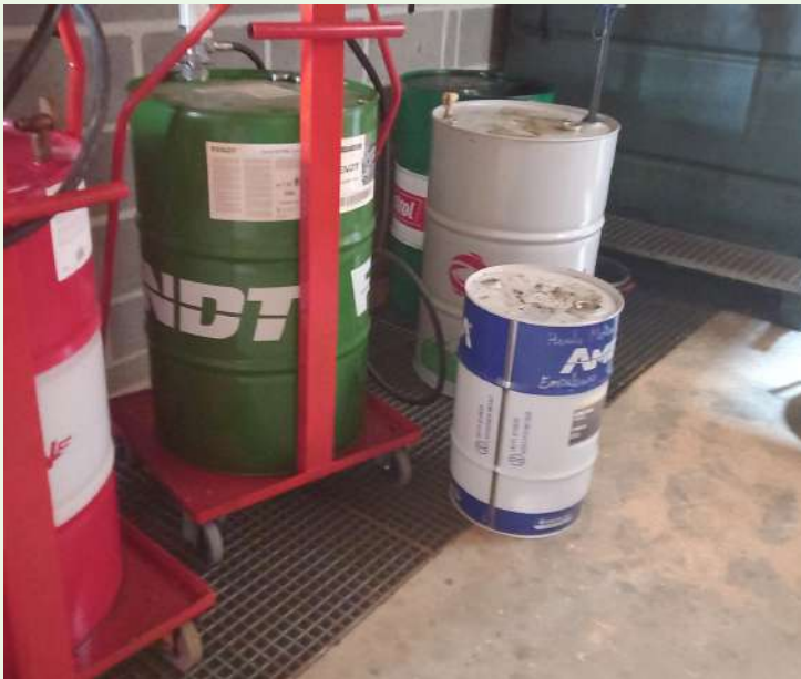
la rétention avec fosse limite les efforts dû au déplacement des fûts.
