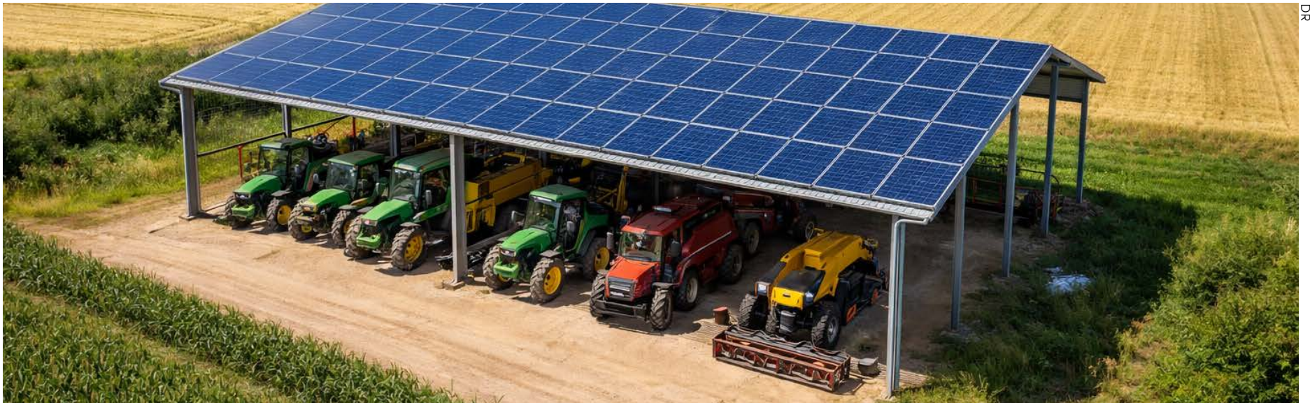
Exemple d'ombrière de Cuma avec panneaux photovoltaïques.
