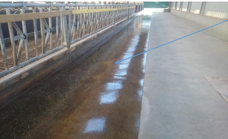
Après lavage, ponçage et neutralisation de l'acidité du béton, application d'un primaire époxydique au rouleau ou à la raclette si présence de trou, dans ce cas le primaire est chargé de silice pour remplir les cavités
