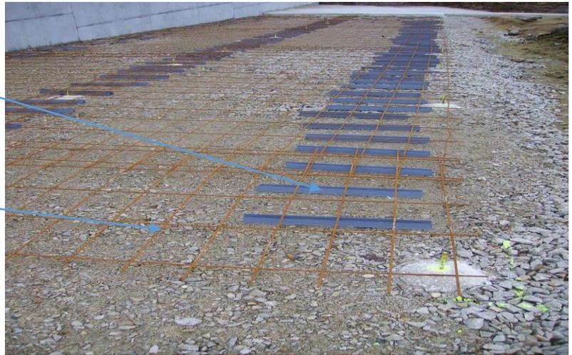
Après réglage et vibration du béton: pose de joint de préfissuration.
