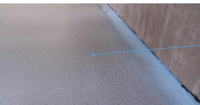
Finition par épandage de silice (antidérapant) et vernis fixateur
