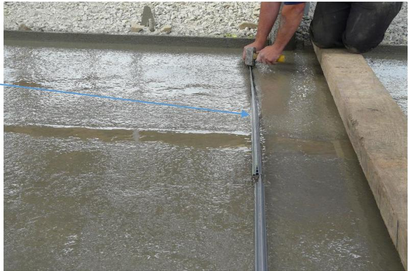
Tout les bétons sont talochés, possibilité de réaliser un rainurage sur béton frais (recommandé par l'institut de l'élevage) pour les aires d'exercices, ou tout autres passages d'animaux.
